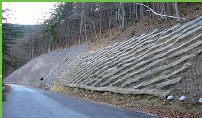
Preprečevanje padanja kamenja z visečo mrežo ter Biotec Vegetation Strips® vegetacijskimi pasovi.
