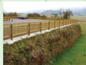
Uporaba sonaravne tehnologije za zagotavljanje stabilnosti in estetskega vida parkirišča.
