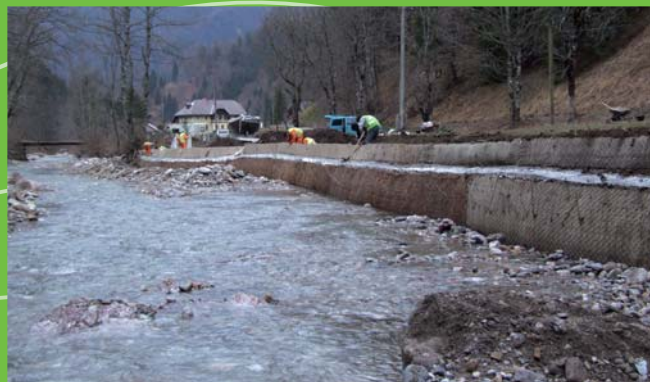
Sanacija brežine ob vodotoku z montažo armirane zemljine Biotec Vegetation Strips®.
