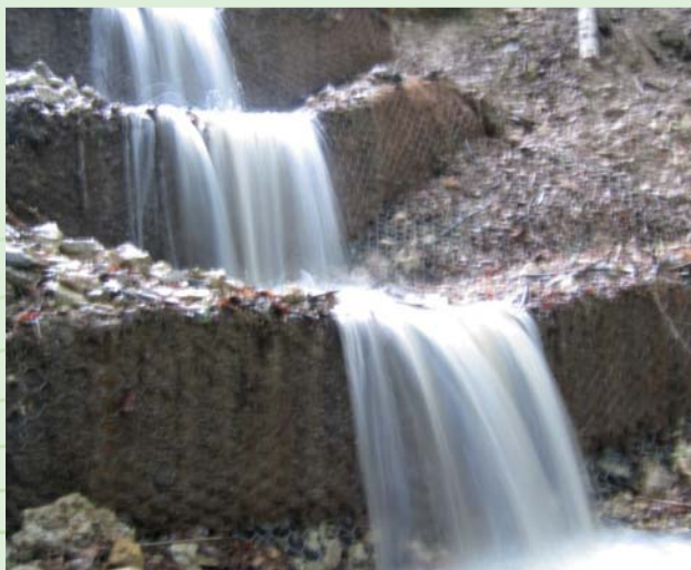
Sanacija struge vodotoka s kaskadnim sistemom montaže armirane zemljine Biotec Vegetation Strips®.
