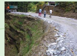
Stabilizacija podporne brežine cestišča.
