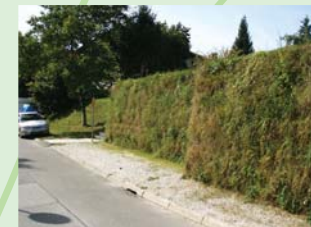
Sivi betonski zid lahko nadomestimo z zelenim travnatim zidom, ki poleg stabilnosti nudi tudi prijeten videz za oko.
