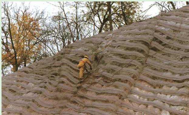
Montaža Biotec Vegetation Strips® vegetacijskih pasov in ...
