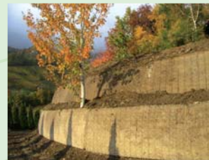
Stabilizacija brežine na sonaraven način z upoštevanjem predhodne vegetacije.
