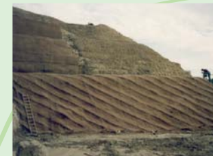
Stabilizacija s pomočjo Biotec Vegetation Strips® vegetacijskimi pasovi na večjem objektu.
