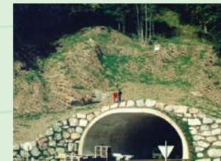
Biotehniška sanacija brežine nad kamnito izložbo vhoda v tunel.
